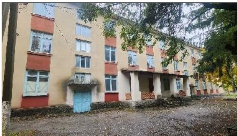
Fig. 1.9 Fațada blocului rezidențial orientată spre E.
