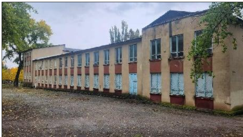
Fig. 1.6.Fațada blocului principal orientată spre V.
