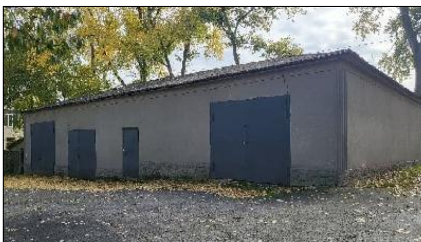
Fig. 1.13 Construcție auxiliară - garaj.
