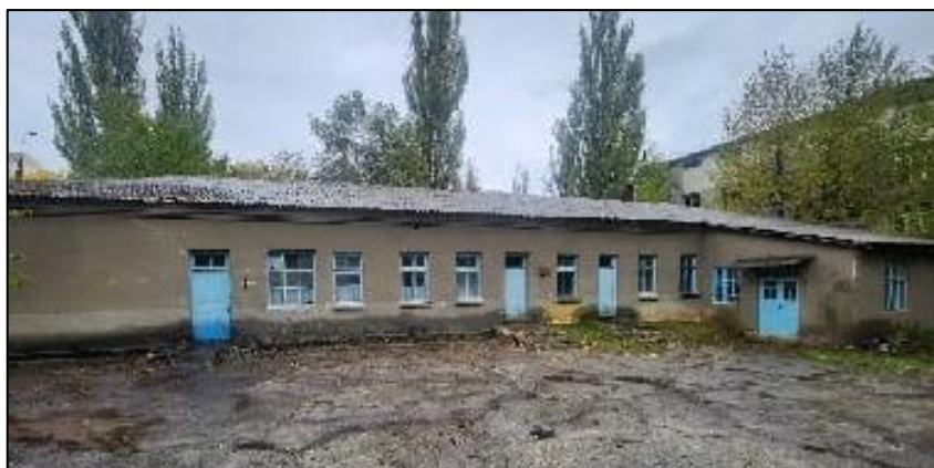
Fig. 1.12 Construcție auxiliară - spălătorie.
