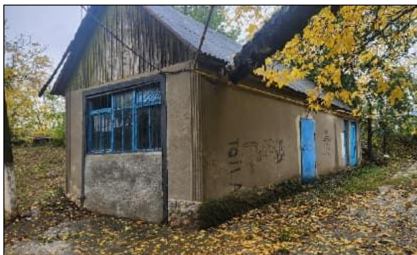
Fig. 1.14 Construcție auxiliară - cazangerie.
