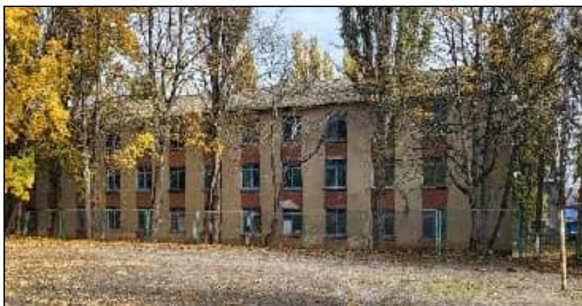
Fig. 1.8. Fațada blocului rezidențial orientată spre V.
