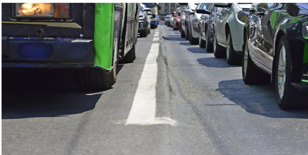
Figura 1.1. Carosabil degradat în traficul rutier
