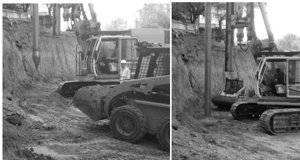
Fig. 5. Executarea coloanelor de pământ vibropresate cu ajutorul instalației RG
