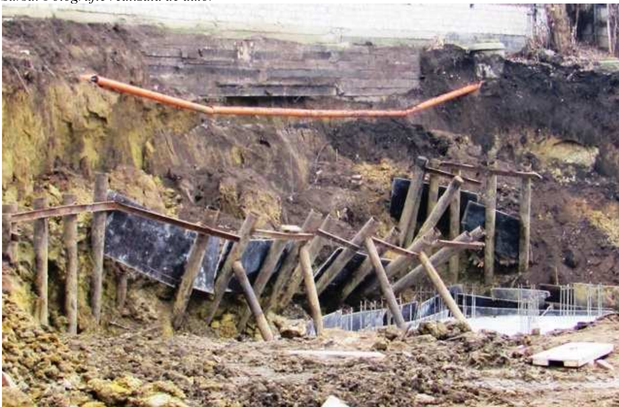
Fig. 4.2. Deformații de alunecare ca urmare a tăierii versantului. Chișinău, Buiucani.
