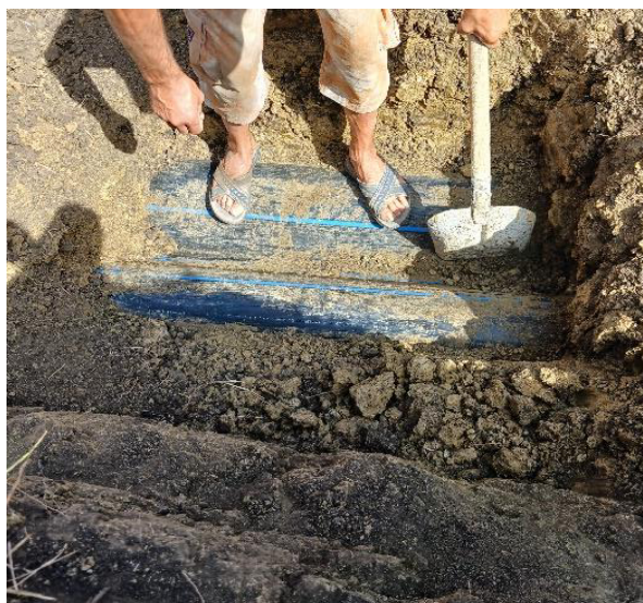
Foto 6. Vedere, pământ scos de pe suprafața tubului
