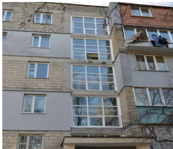
Figura 1. Bloc locativ din Chișinău, termoizolat de către locatari.
