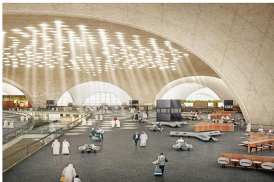
Figura 8. Arcurile catenare ale Aeroportului Internațional din Kuwait
