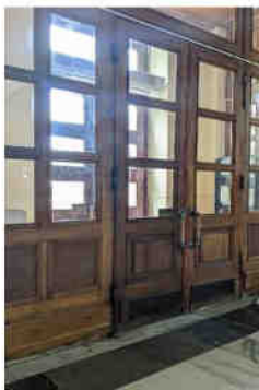
Foto-L. Platon □ Figura 26. Ușa centrală, realizare veche din lemn. □
