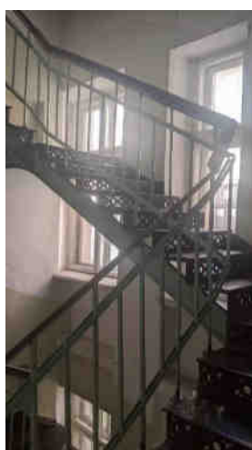
Foto L. Platon Figura 18. Scara veche laterală, realizată din fontă.
