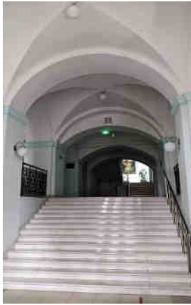
Foto L. Platon Figura 24. Scara centrală. Bolta în arcuri încrucișate.
