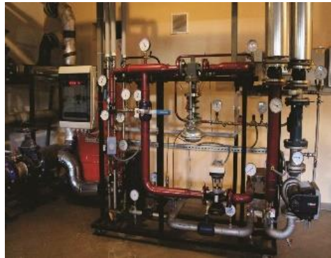
Figura 1. Construcția unui PTI
