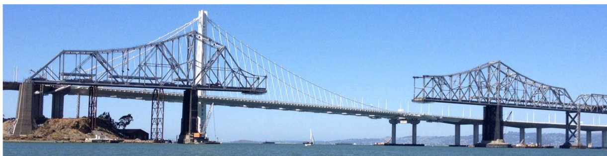
Figura 5. Demontarea unui pod in console[10]
