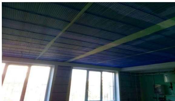
Figura 3. Poziții de montaj a covoarelor de capilare Clina aplicate pe elementele de anvelopă a încăperii experimentate
