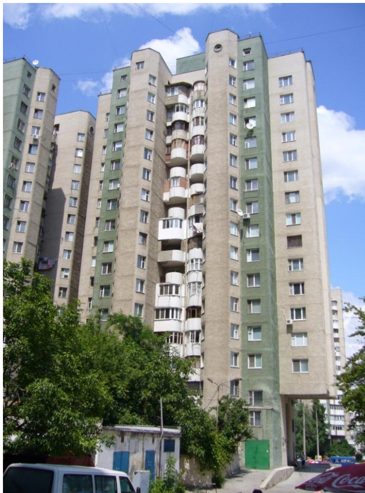
Рис. 1.7. Монолитное здание с подрезкой стен нижних этажей.
