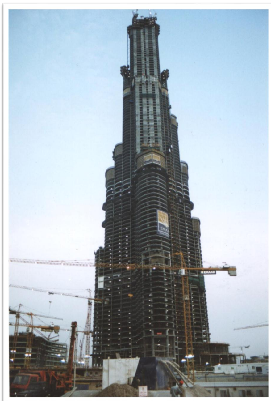
Рис.1.1.Монолитное здание в Дубае (Саудовская Арабия) высотой 828 м.
