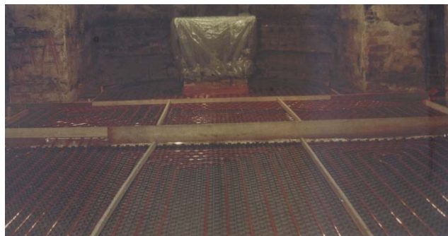
Fig. 2. Sisteme de încălzire în pardoseală [19].
