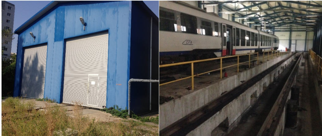
Fig. 1. Hală de reparații automotoare Desiro.
