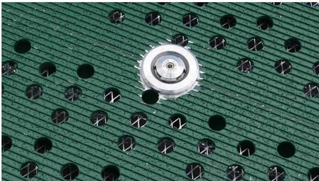
Figura 2. Cap de sprinkler pentru heliport (surse proprii)
