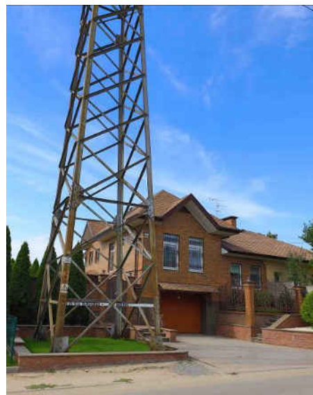
Рис. 2. Расположение жилого дома новой постройки в непосредственной близости от опоры ЛЭП. 2
