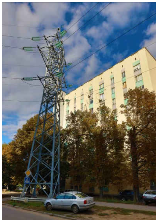
Рис. 1. Расположение многоэтажного жилого дома в непосредственной близости от ЛЭП. 1
