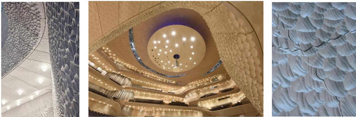
Рисунок 1. Отделка стены и потолка концертного зала Эльбской филармонии [6].
