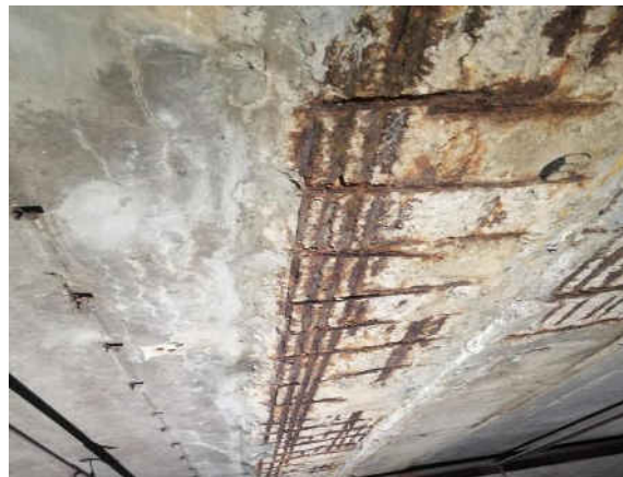
Figura 1. Coroziunea armăturii [2]
