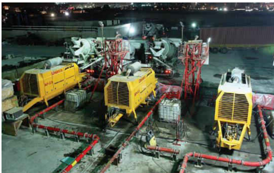
Figura 3. Metoda de pompare a betonului la construcția obiectivului Burj Khalifa
