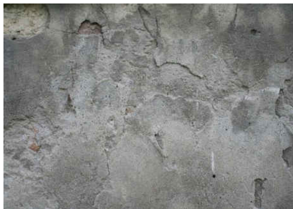
Figura 2. Degradarea Chimica [2]
