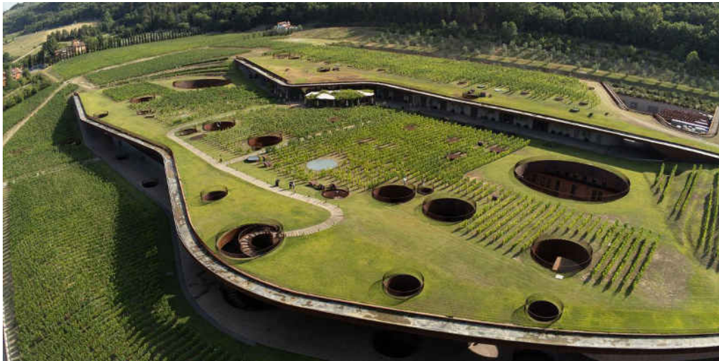
Figura 3. Perspectiva pasarelă a Complexului Vitivinocol, vedere spre fațada principală și orificiile pe acoperiș prin care pătrunde lumina naturală
