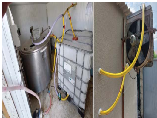
Fig. 3. Instalația frigorifică (Foto)
