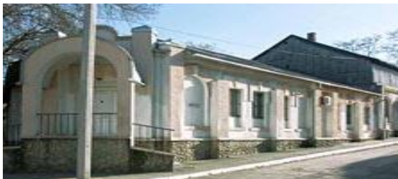
Brutărie str. Cojocarilor 19
