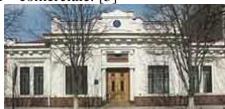
Fosta bancă str. Vlaicu Pîrcălab 55 B
