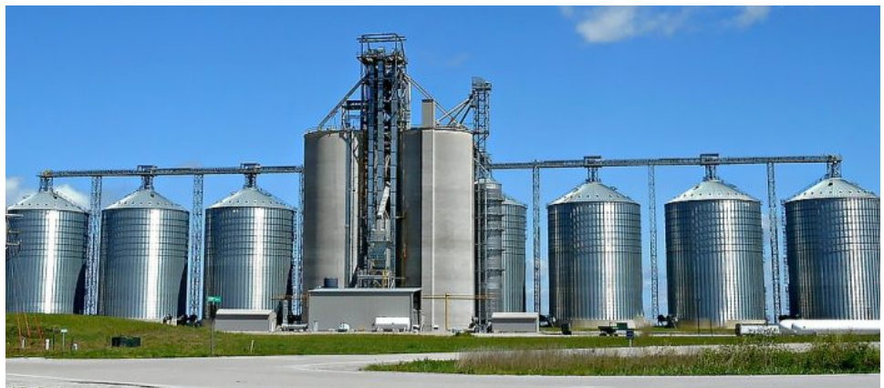
Fig. 3.30. Stație modernă de recepție , condiționare și depozitare produse agricole, întâlnită și la marii producători agricoli din România
