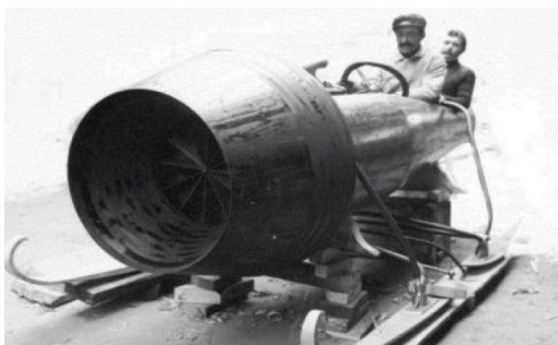
Fig. 3. O machetă a avionului Coandă 1910 și o sanie echipată cu motor reactiv.
