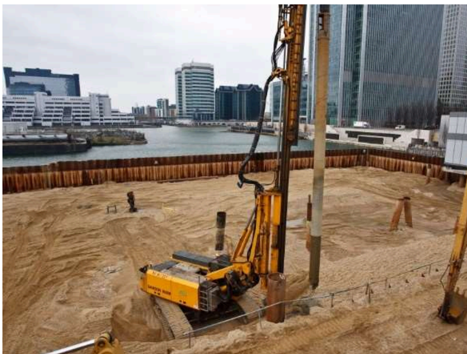
Fig. 2 Montarea piloților în interiorul cofferdamului [6]
