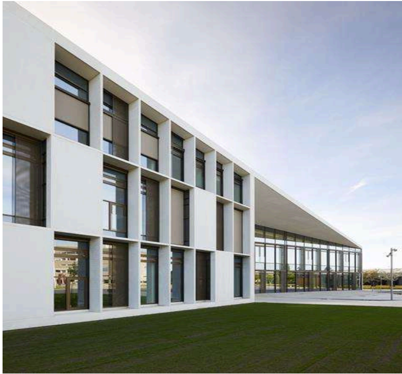
Fig. 3 Fațade din beton de ultra-înaltă performanță
