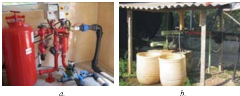
Fig. 60. Aspectul sistemului de fertirigare: a- cu "tanc" de fertilizare; b. - cu injector "venturi" (foto A. Overcenco).
