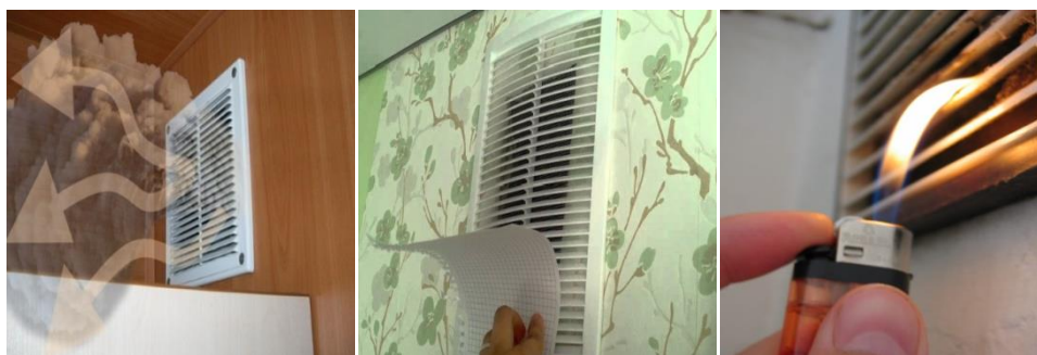
Figura 2. Tirajului natural invers cu mirosuri străine, provenite de la vecini (poza 3-tiraj natural normal) [2]
