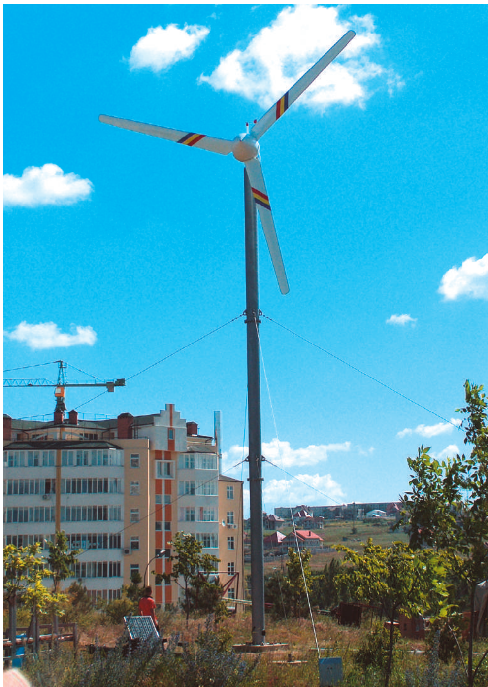
Fig. 3.21. Turbină eoliană cu turn tubular instalată în campusul Râșcani, UTM.
