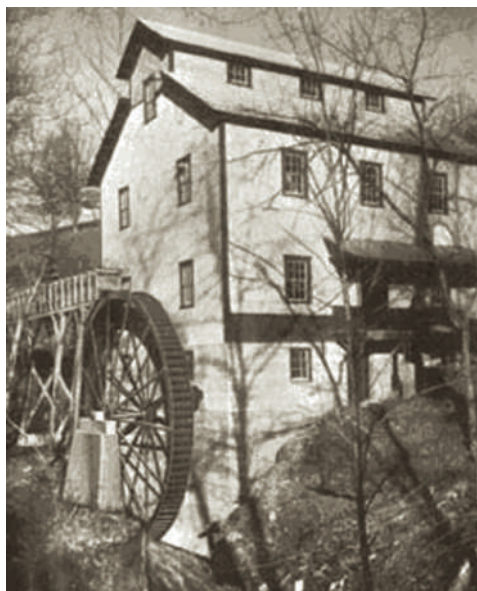
Fig. 2.8. Roata de apă legată prin transmisii mecanice cu mașina de lucru.
