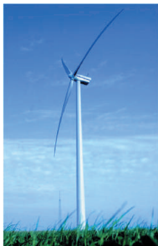
Fig. 3.14. Turbină modernă cu 3 pale
