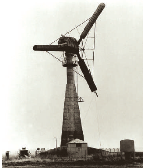
Fig. 3.7. Prima turbină construită conform „Conceptului danez” de J. Juul în localitatea Gedser, Danemarca.
