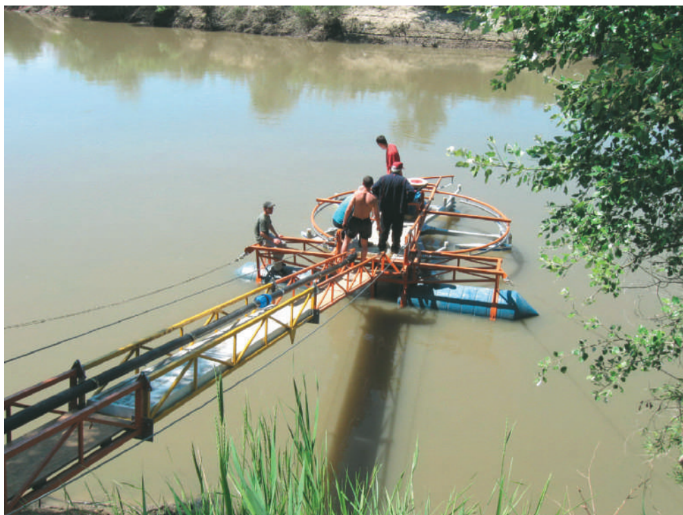
Fig. 2.97. Prototipul industrial al microhidrocentralei fabricat instalat pe poligonul de încercări de pe r. Prut în c. Stoieniști, Cantemir.
