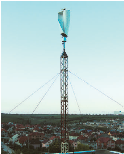
Fig. 3.53. Vederea generală a REEV instalat pe turnul universal de încercări.
